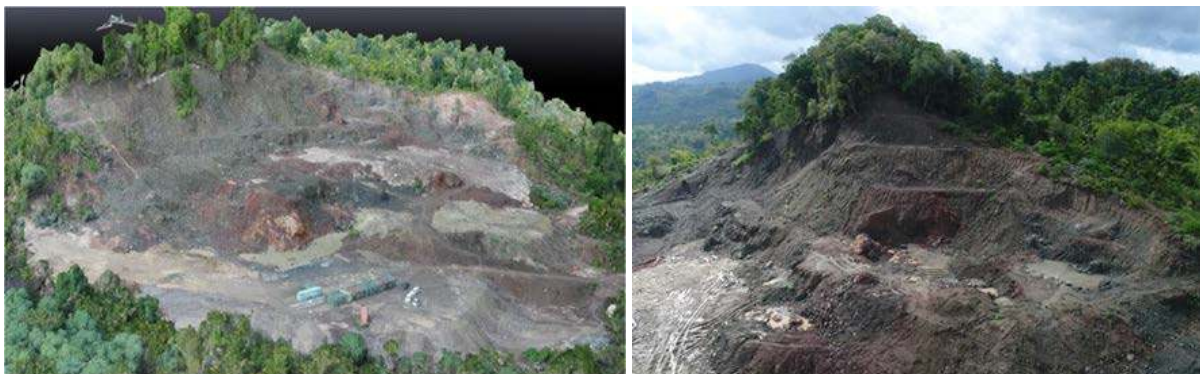
FIGURA 45: KONDISAUN KORI ANTES HALO REHABILITASAUN
