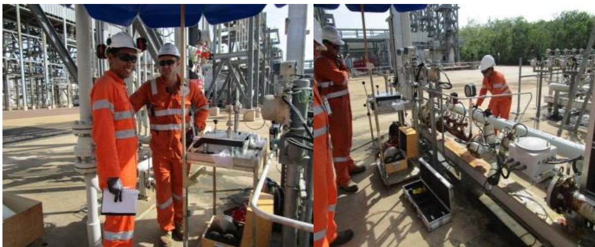
FIGURA 22: EKIPA SASUKAT HALA'O INSPESAUN IHA FASILIDADE DLNG
