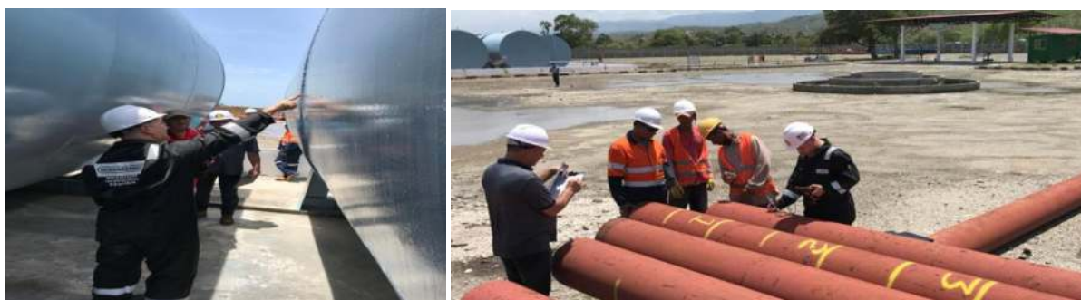
FIGURA 37: INSPESAUN BA RESERVATORIU NO TUBAGEM KOMPAÑA LAI-ARA NIKMAT MUJUR, KAITEHU LIQUIÇA
