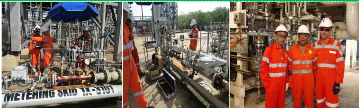
FIGURA 15: EKIPA SASUKAT HALA'O INSPESAUN IHA FASILIDADE DLNG
